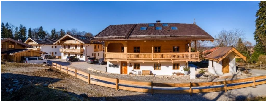
Fünf neue stilvolle Häuser in der Hadergasse
