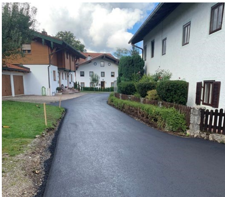
Foto: Instandsetzung Straße Egerndach 2022
