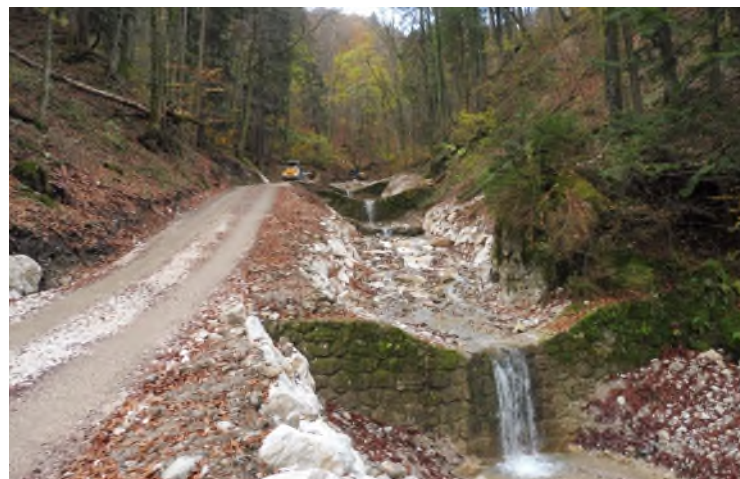
Weidenbach (Foto: Wasserwirtschaftsamt)
