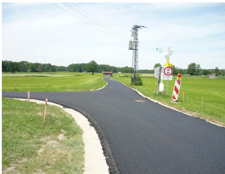
Straße Hub nach Sanierung
