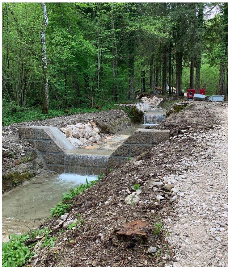
Hochwasserverbauung in Avenhausen
